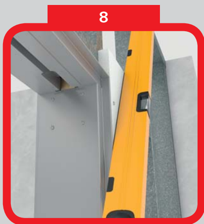
Upravte horní omítníky, aby lícovaly s SDK deskou
