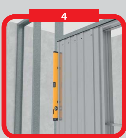
Vyvažte pouzdro vertikálně
